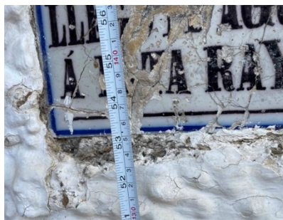
Escaneo del estado de conservación de la pieza donde pueden observarse todos los daños
