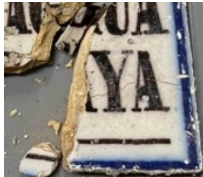
Durante la intervención se comprobó que el estado de conservación era más deficiente de lo inicialmente apreciado en la inspección visual realizada in situ.
